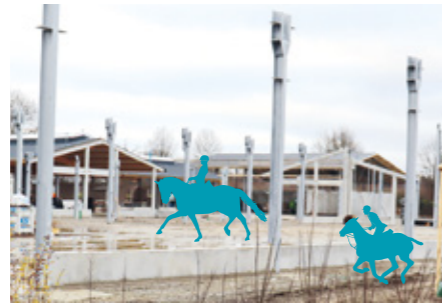
Stillgelegt: Nach einer Entscheidung des Verwaltungsgerichts ruht der Baubetrieb.
