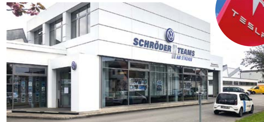
Am Stadion: Noch geht es an der Sportstraße vor allem um VW-Nutzfahrzeuge. Möglicherweise stehen schon bald die flotten Tesla-E-Autos in der Halle.
