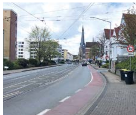
Standort: Hier an der Ecke Heuberger Straße soll der Hochbahnsteig gebaut werden.
