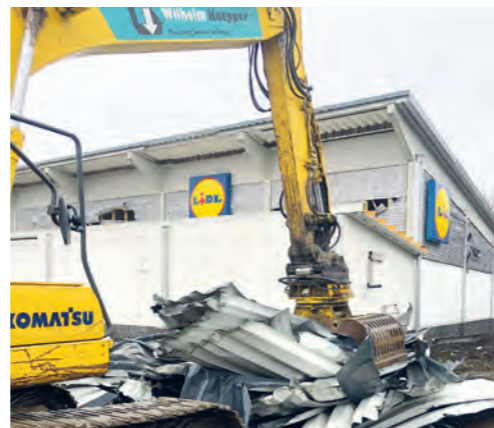
Auslaufmodell: Der alte Lidl am Stadtring hat ausgedient und wird abgerissen.
